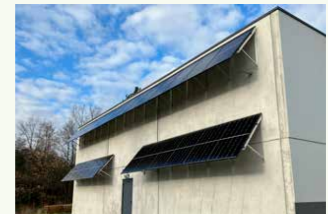
Gevelmontage van zonnepanelen in Verviers
